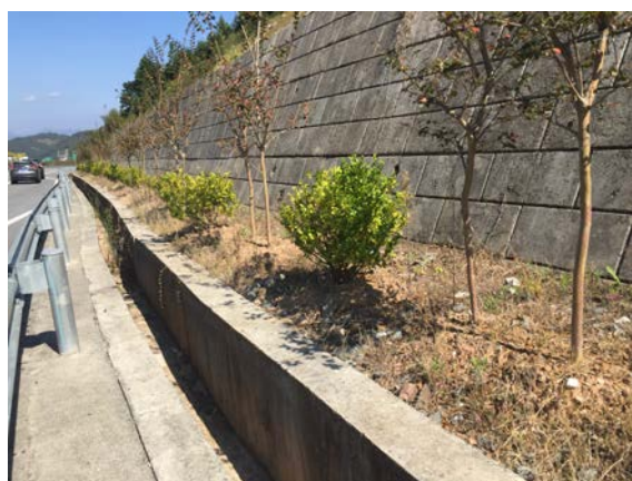
主线路基浆砌石边沟
