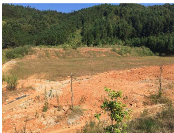
K41+471 弃渣场恢复现状
