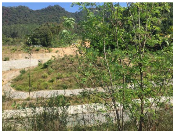
来舟互通匝道弃渣场恢复现状
