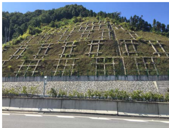
挖方路基浆砌骨架护坡
