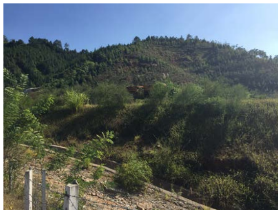
将军隧道出口弃渣场恢复现状
